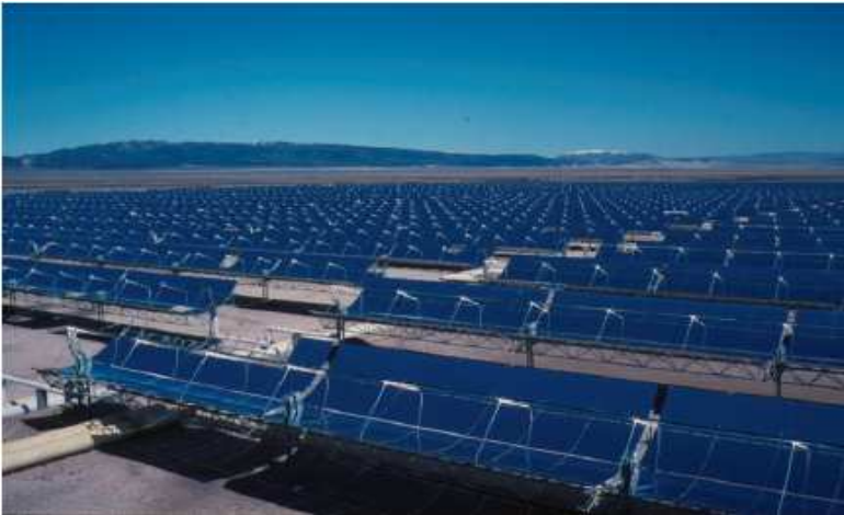
Sistema de geradores de Energia Solar (SEGS), California, USA
