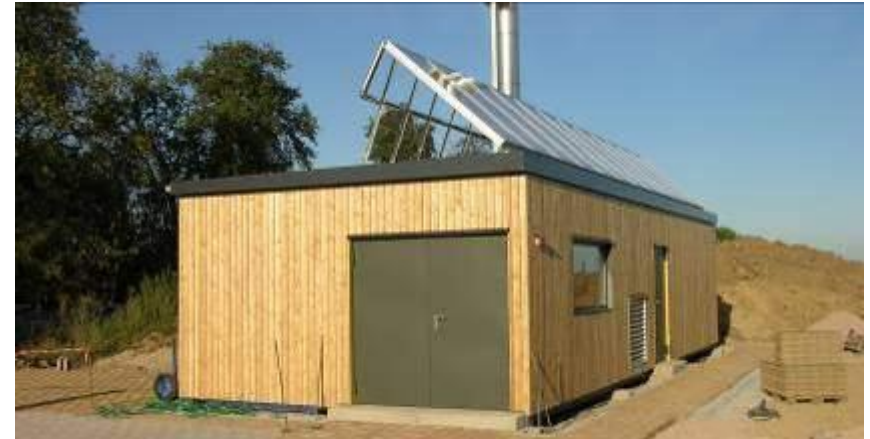
Energiekabine am Firmensitz der juwi-Gruppe in Wörrstadt
