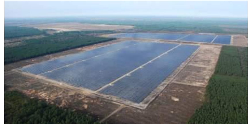
Freiflächenanlage in Lieberose, Brandenburg
