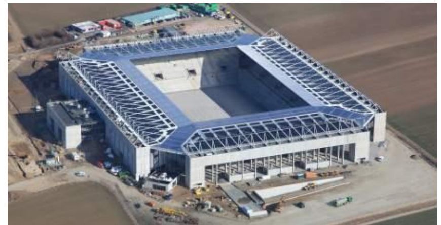
Dachanlage auf dem neuen Stadion des 1. FSV Mainz 05
