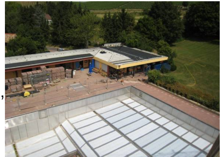
Freibadsanierung während der Bauphase
